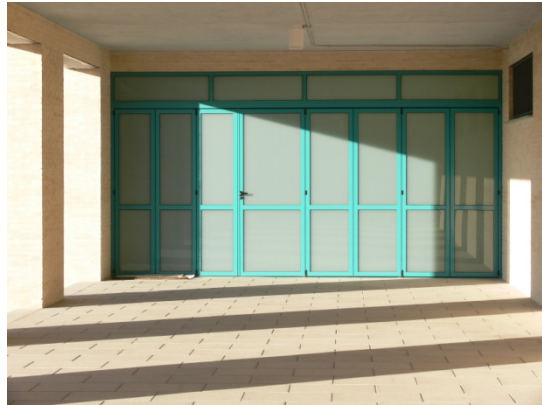
Porta d'entrada a la cafeteria
